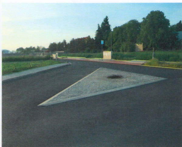
Křižovatka místních komunikací
