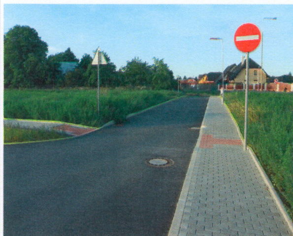
Komunikace ze živice, chodníky ze zámkové dlažby
