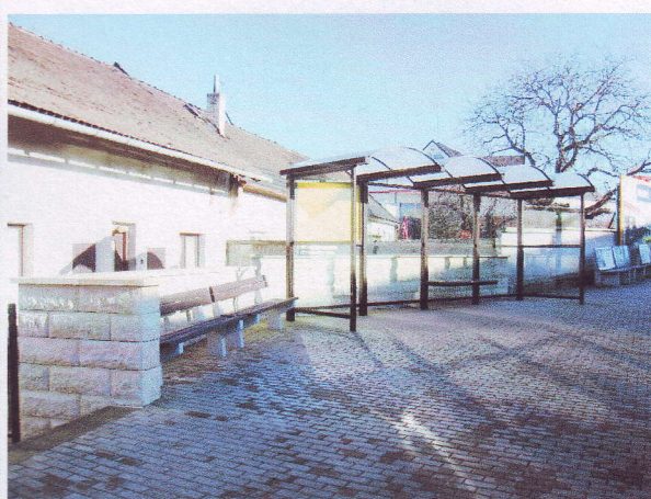
Zastávka MHD včetně přístřešku a laviček
