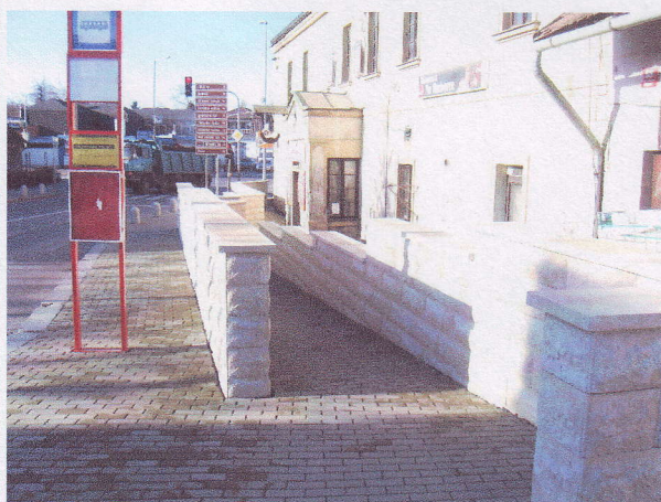
Rampa u zastávky MHD
