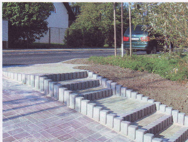
Schodiště – zámková dlažba
