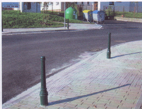
Komunikace živice, chodník zámková dlažba – reliéfní dlažba pro nevidomé
