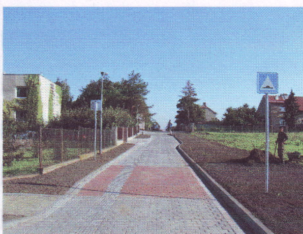
Komunikace zámková dlažba, zpomalovací pruhy, sadové úpravy
