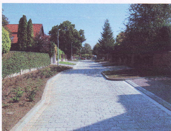
Komunikace zámková dlažba včetně sadových úprav
