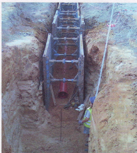
Použití pažicích boxů
