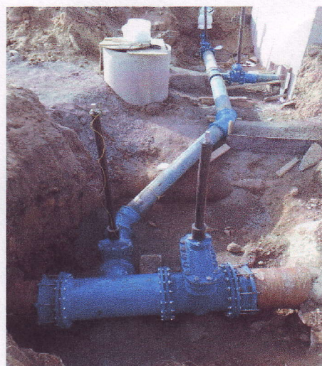
Přípojka vody vč. vodoměrné šachty
