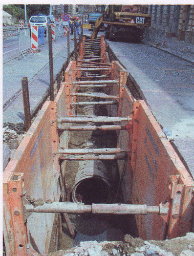
Stoka KT DN 1000 v zapážené rýze – práce za provozu
