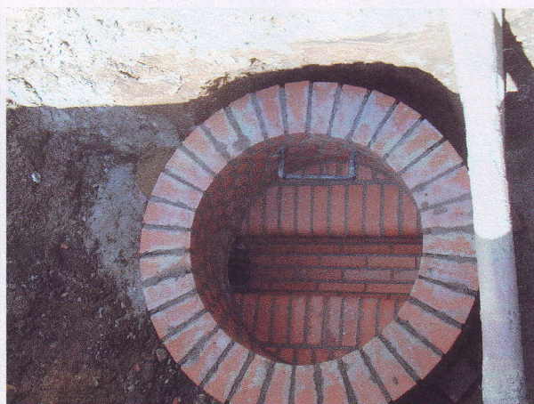
Dno šachty z kanalizačních cihel
