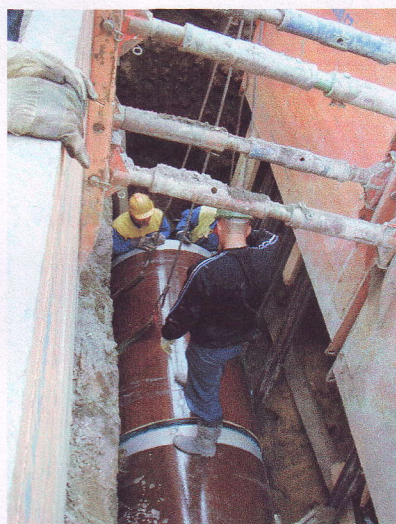
Ukládka kanalizačního potrubí KT DN 1000
