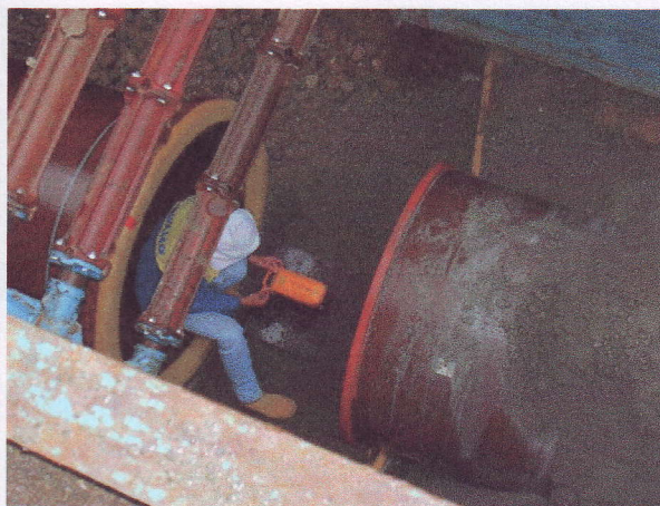
Práce s potrubním laserem při pokládce kanalizačního potrubí, Kamenina DN 1000
