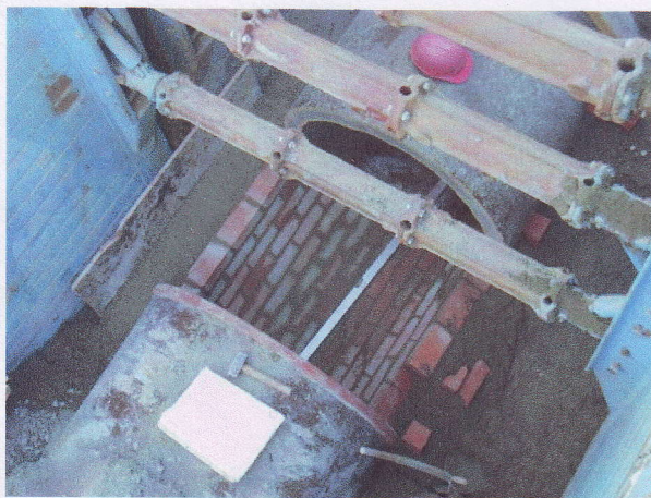
Vyzdívka z kanalizačních cihel – dno revizní šachty na kanalizačním potrubí kamenina DN 1000
