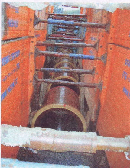
Pažící boxy a pokládka kanalizační rour – kamenina DN 1000
